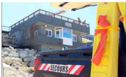
Le poste de secours compte cinq NS-CRS. PHOTO JDM
