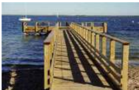
Le nouveau ponton de Maubuisson. P. M.
