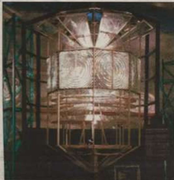
Premier appareil lentillaire à feux tournants installé au phare de Cordouan par Augustin Fresnel en 1823.
