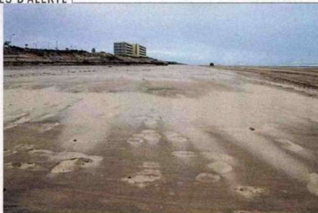
LE SIGNAL, construit trop près de mer (ici, en 2020).
