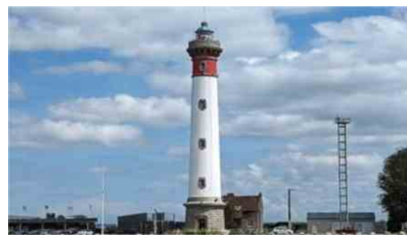
La demi-lentille de Fresnel est située en haut du phare de Ouistreham : le signal lumineux émis par le phare est perçu à près de 30 km.
