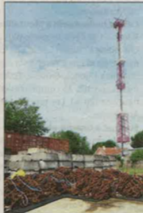
Les corps-morts de 2 à 5 tonnes sont fabriqués sur place et attachés à des chaînes mesurant trois fois la hauteur d'eau de pleine mer avec un coefficient de 95.
