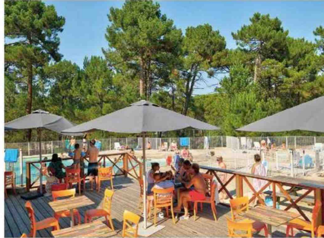
La réhabilitation du village vacances des Oyats - Sylvadoures, à Carcans-Maubuisson en Gironde, pour un coût de 5,2 M€, a permis la rénovation des 177 chalets.
